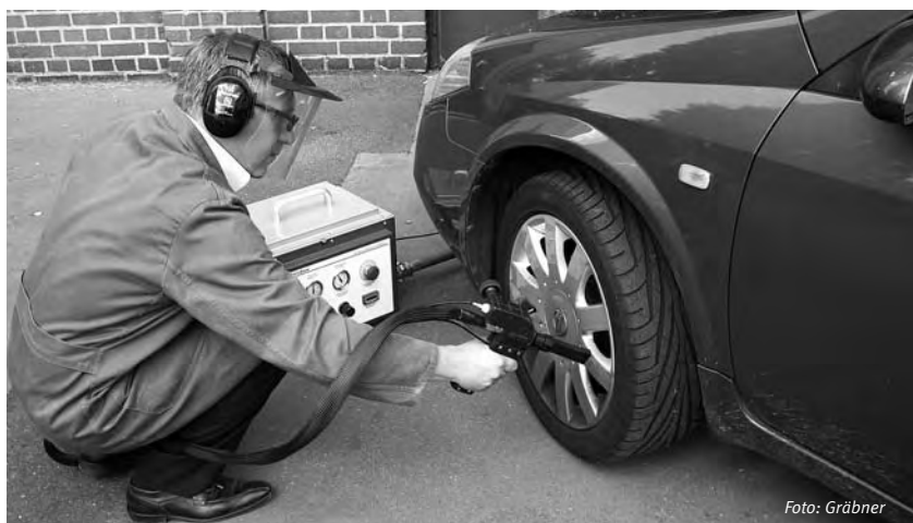
Felix Elbing säubert eine Felge mit dem CO 2 -Schneestrahlergerät SJ-10
